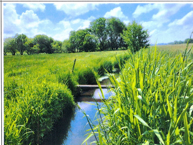
Photos n°6 : vue intermédiaire des travaux ruisseau de la Marguerie
