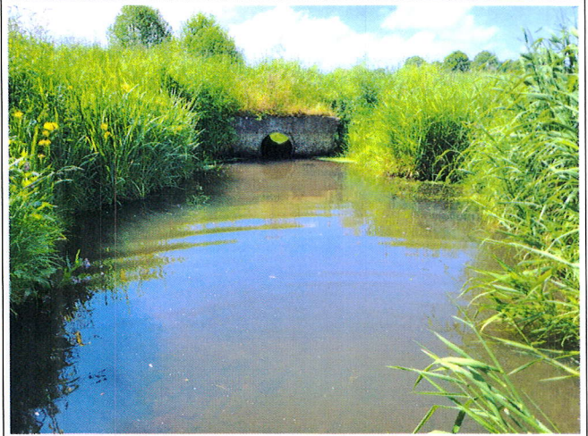
Photos n°8 : vue amont des travaux
