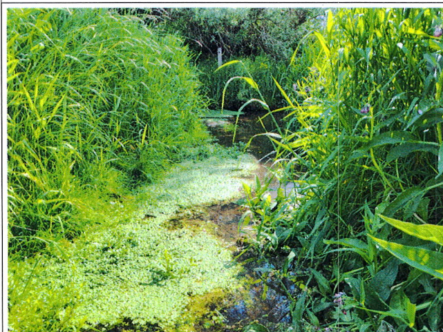
Photo n°5 : vue fin des travaux ruisseau de la Fontaine du Routeux et partie aval ruisseau de la Marguerie
